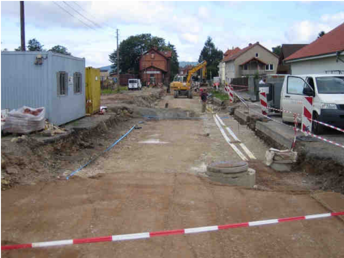
Beginn der Ausbaurbeiten zur Neugestaltung der Ortsmitte in Duingen Anfang 2009
